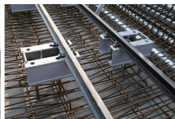
나. Inner Formwork 지지 block
