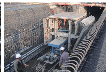
다. Inner Formwork 이동
